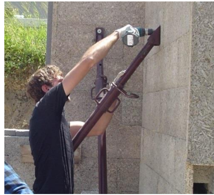
Befestigung Steher (muss am Steg angeschraubt werden)
